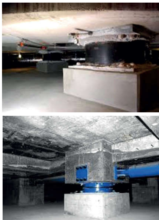
Рис.1. Резинометаллическая (а) и скользящая (б) опора
